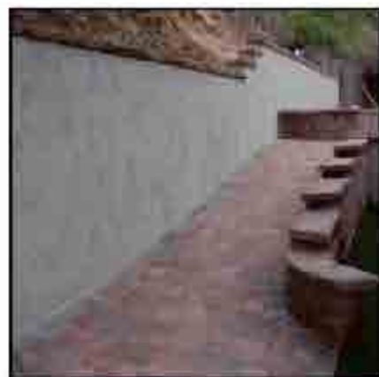
圖2-64 磚面無障礙坡道
