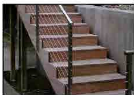
圖3-24 露空階梯加設木板
