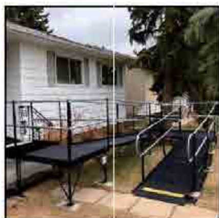
圖2-65 鐵架無障礙坡道
